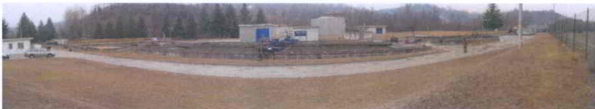
Vista d'insieme dell'area interessata.
