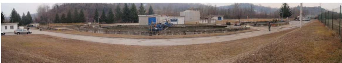
Vista d'insieme dell'area interessata.
